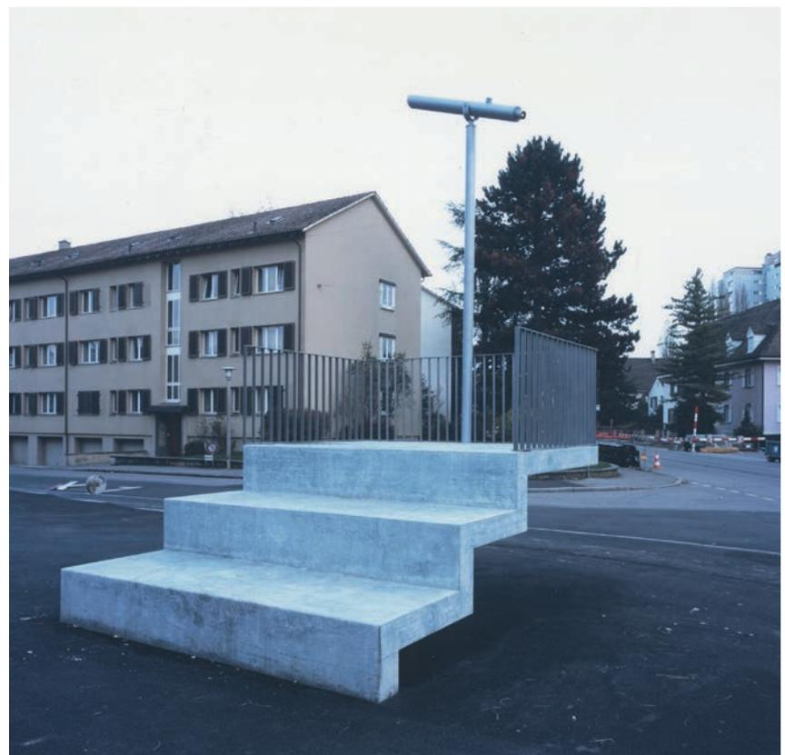
Treppenelement und Plattform aus eingefärbtem Beton
