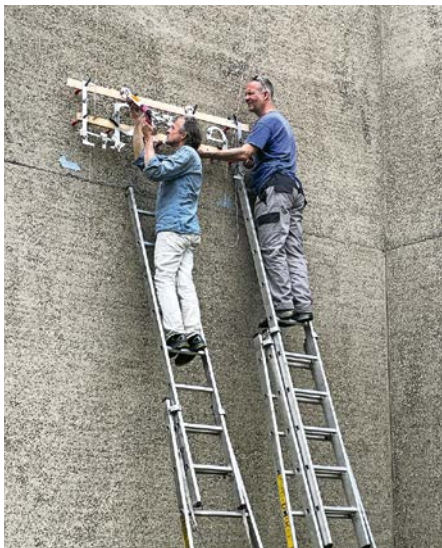
Die Zeichen aus Chromstahl wurden mit einer Distanz von 1,5 Zentimeter zur Fassade montiert.
